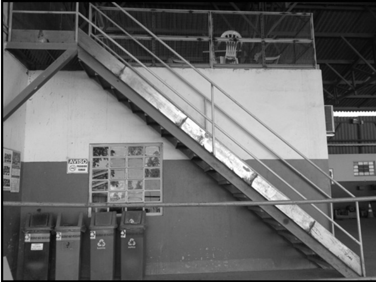
Figura 4 – Implantação de guarda corpo e roda na escada.
