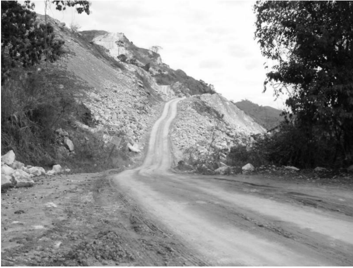
Figura 2 – Via de acesso que tem risco de queda de equipamento e veículo, onde a mesma não tem proteção em suas bordas.
