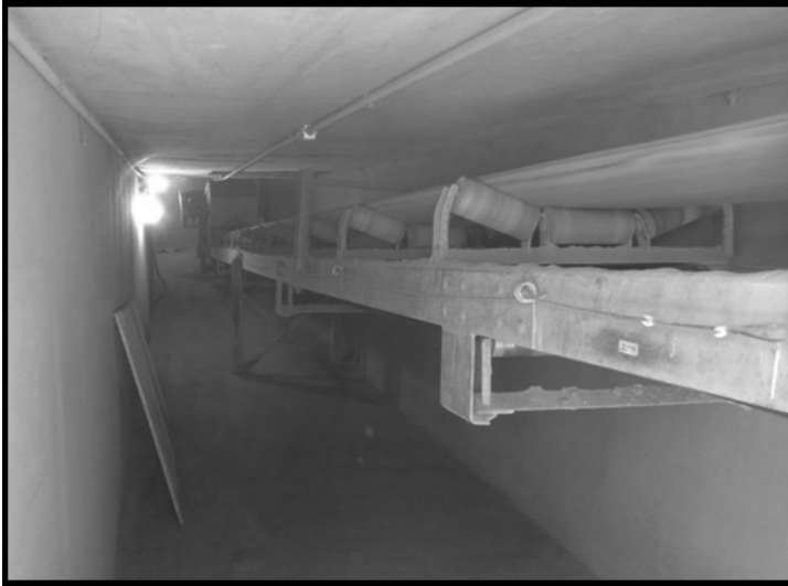
Figura 3 – Parte móvel de equipamentos sem proteção.
