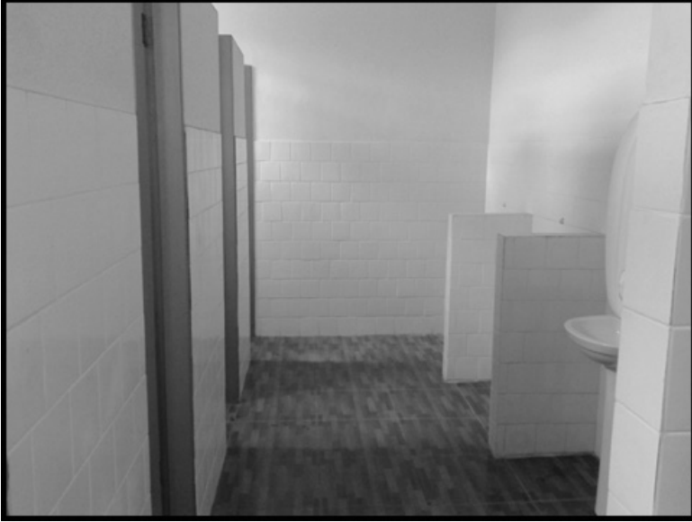
Figura 5 – Adequação de sanitários para atender às normas regulamentadoras.
