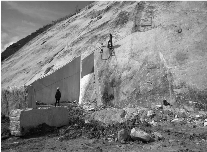
Figura 4 – Trabalhador em piso inclinado sem a utilização de cinto de segurança para impedir a sua queda em caso de escorregão.
