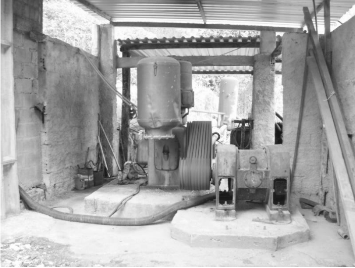
Figura 3 – Equipamento com partes móveis desprotegidas, permitindo a ocorrência de acidentes.
